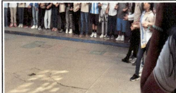
Foto 2: deterioro de los tragantes del drenaje de agua pluvial. Ubicados en el patio.
