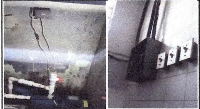
Foto 8: Reparación de sistema eléctrico de bomba de agua, debido a que ya tiene mucho tiempo y tiende a sobrecalentar y bajar el flipón cuando se enciende la bomba por mas de 20 minutos. Peligro de corto circuito.
