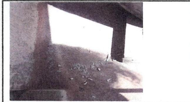
Foto 5: Piso antideslizante sobre loza que sostiene tinaco de la cocina debido a acumulación de agua y filtraciones en techo en epoca lluviosa.
