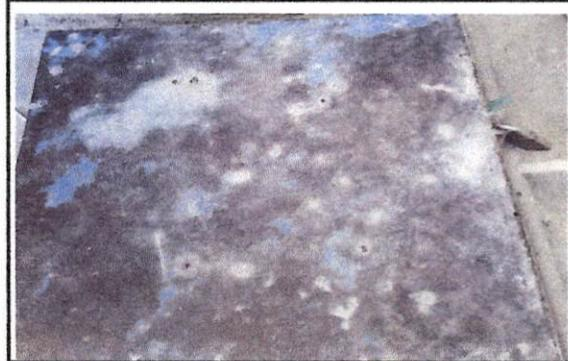
Foto 2: Desmontaje, suministro e instalación de compuerta de cisterna de agua. Debido a que la actual ya esta corroído el metal.
