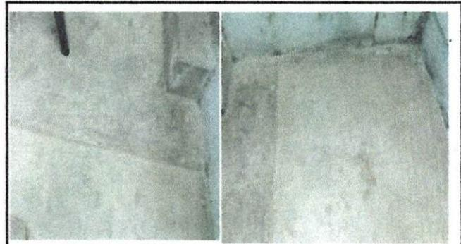
Foto 6: Colocación de Piso de granito y zocalo de azulejo en bodega debido a humedad de suelo y paredes.
