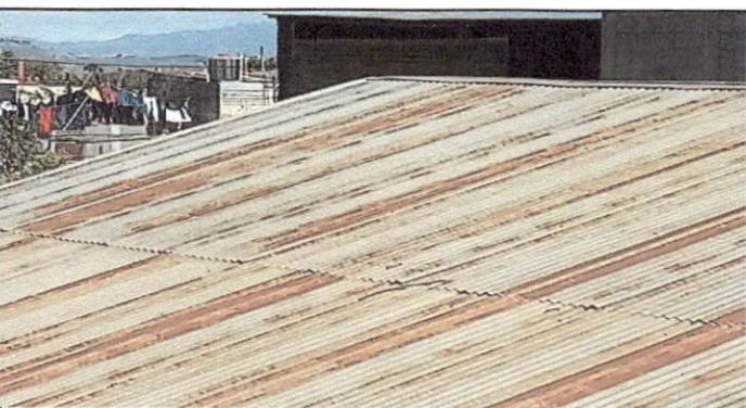
Foto 4: desmontado e instalación de láminas y estructura nueva de 3 aulas del modulo de preprimaria
