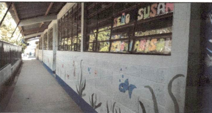
Foto 6: Pintura exterior frontal de 3 aulas módulo de preprimaria
