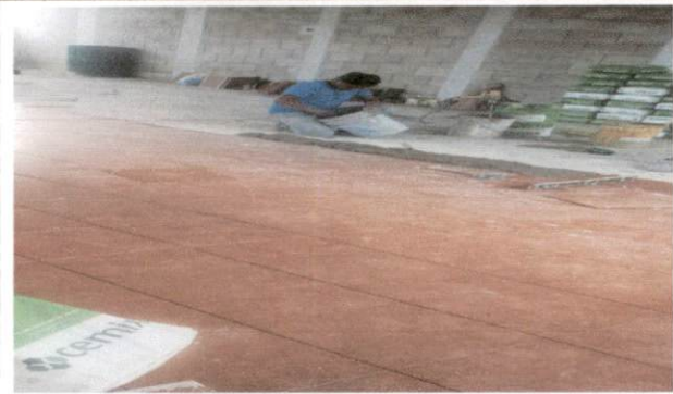
Foto 2: Instalación de piso cerámico dentro de los dos salones segundo nivel.
