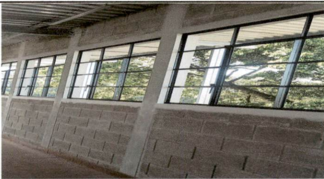
Foto 5: Instalación de ventanas en los dos salones del segundo nivel
