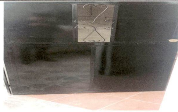
Foto 4: Instalación de puertas de metal de las dos entradas de los salones segundo nivel.
