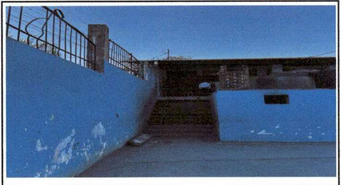
Foto 2: imagen que muestra la vista panoramica del módulo 2 y de la entrada al aula para proyecto y el area de entrada a los salones previstos para remozamiento.
