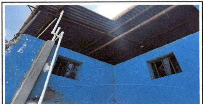
Foto 6: imagen que muestra la vista de ángulo derecho que conduce al salón que se tiene previsto el cambio de lámina por techo de losa.
