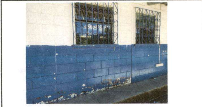
Foto 3: Pintura exterior de paredes, modulo 2.
