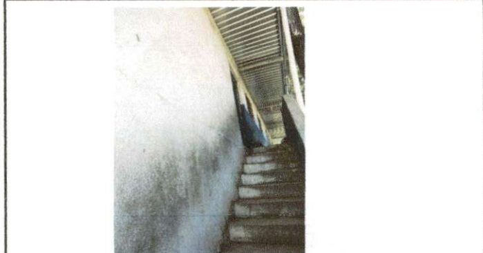
Foto 4: Pintura exterior de paredes, modulo 3.
