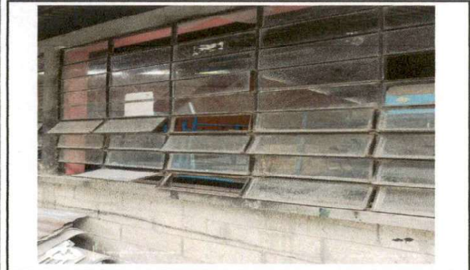
Foto 9: Imagen que muestra el mal estado de las ventanas.
