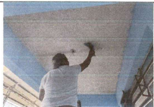
Foto 6: proceso de colocacion de lamparas
