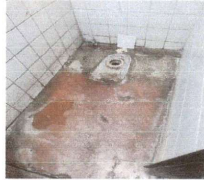
Foto 2: proceso de sustición de sanitarios
