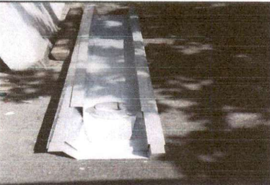
Foto 5: proceso de colocacion de canal
