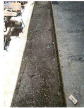
Foto 6: Reparación de plancha de concretol
