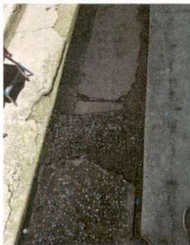
Foto 5: Reparación de plancha de concreto
