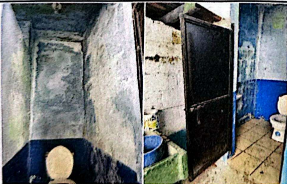
Foto 5: Batería de baños en malas condiciones, presentando problemas de humedad y fisuras.
