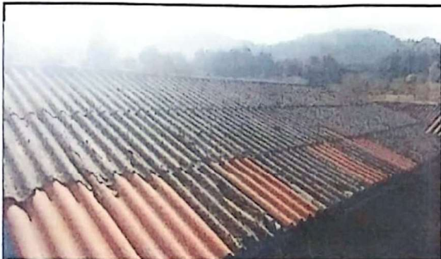
Foto No. 6 esta imagen muestra el deterioro de la lámina duralita en la parte exterior del techo de los salones
