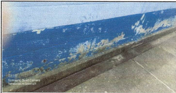
Foto 5: Situación actual de la cuneta.
