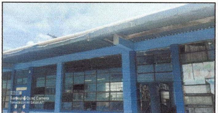
Foto 6: Situación actual del canal.
