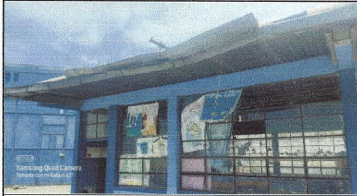
Foto 1: Situación actual del canal.
