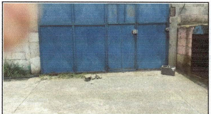
Foto 4: Situación actual del portón.
