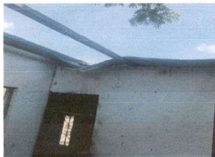
Foto 2: Techo actual del Aula 1 (Párvulos Etapa 5)
