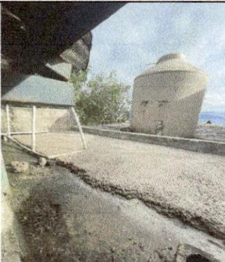
Foto 3: Módulo A, losa con filtración
