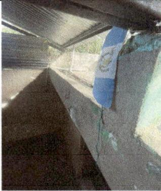
Foto 1: Módulo A, láminas en mal estado que permiten filtraciones
