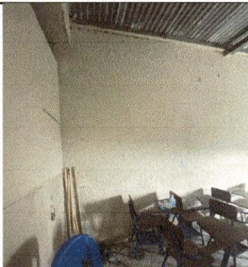
Foto 9: Módulo A, lámina que permite la filtración
