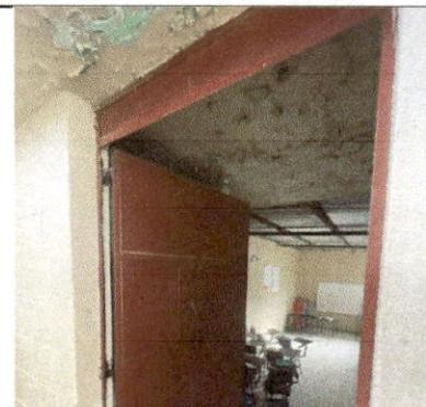
Foto 6: Módulo A, techo en mal estado
