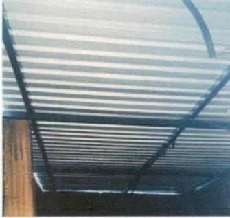
Foto 7: imagen que muestra la lamina troquelada aluzinc calibre 26 ms pintura y tornillos del modulo 1.
