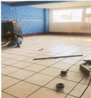
Foto 5: imagen que muestra el area de salon 5 donde se instalando el piso de cerámico del moludo 1
