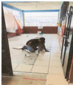
Foto 11: imagen que muestra el area de solon 11 donde se instalando el piso de cerámico del modulo 2
