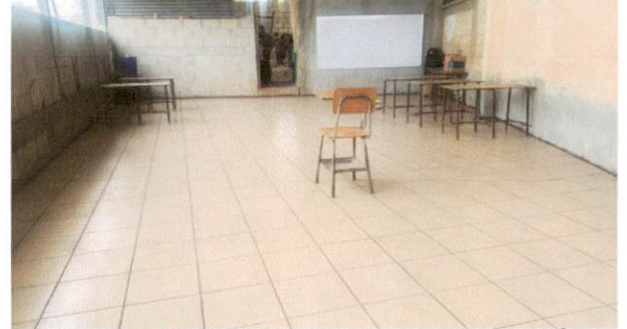
Foto 2: imagen que muestra el area de salon 6 donde se instalando el piso de cerámico del modulo 1
