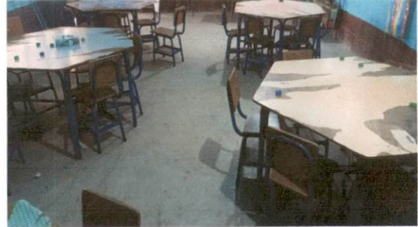
Foto 4: imagen que muestra el area de salon 2 donde se va sustituir e piso de concreto por piso de cerámico.
