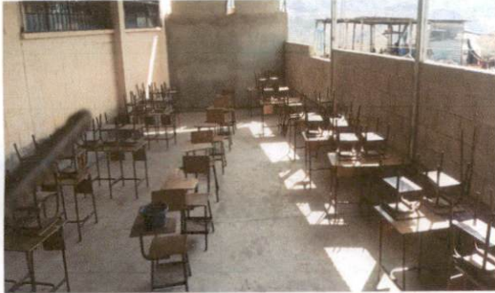
Foto 3: imagen que muestra el area de salon 6 donde se va sustituir e piso de concreto por piso de cerámico.
