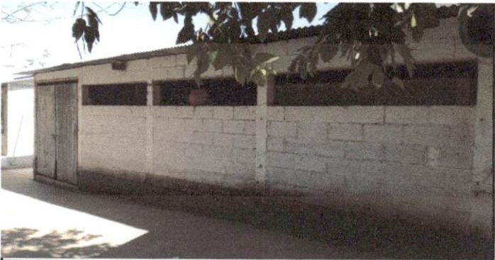
Foto 5: Pintura exterior de bodega
