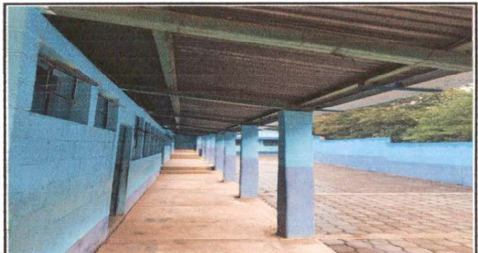
Foto N 4: Área de corredor derecho de los salones de clase.
