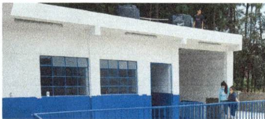
Foto 5: Suministro e instalación de canal
