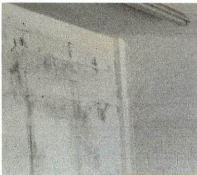
Foto 3: Remozamiento en el exterior de las paredes del establecimiento
