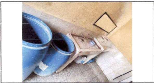
Foto 6: Esta fotografía muestra la sustitución que se harán de los chorros y sustitución de los toneles por pilas en los sanitarios del módulo 2.
