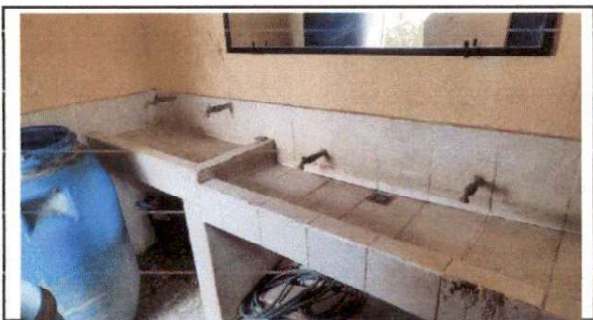
Foto 5: Vesta fotografía muestra la sustitución que se harán de los chorros y sustitución de los toneles por pilas en los sanitarios del módulo 2.
