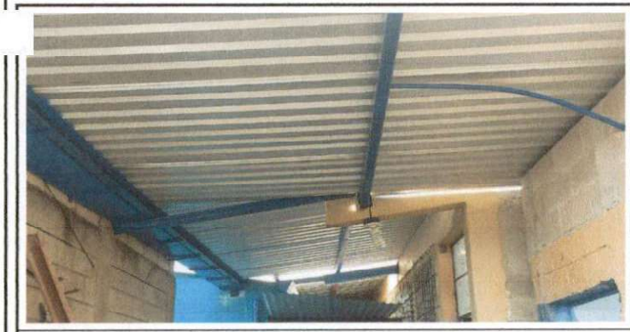
Foto 5: Reemplazo de lámina y costaneras en el pasillo donde se tenía filtración de agua por el estado de lámina y costanera
