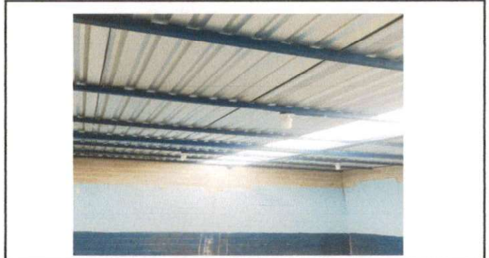
Foto 2: Segundo salón con nueva estructura y cubierta de lámina, esto para mejorar el desnivel y evitar filtraciones
