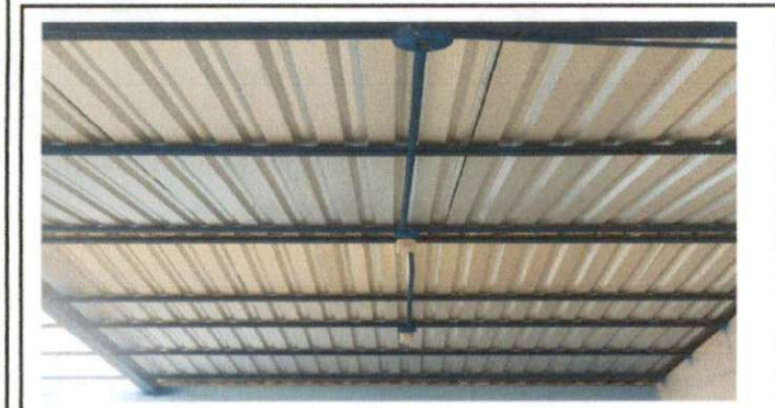
Foto 3: Segundo salón con estructura y lámina troquelada
