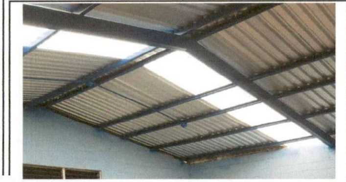
Foto 1: Mantenimiento a la estructura del primer salón y sustitución de lámina por troquelada
