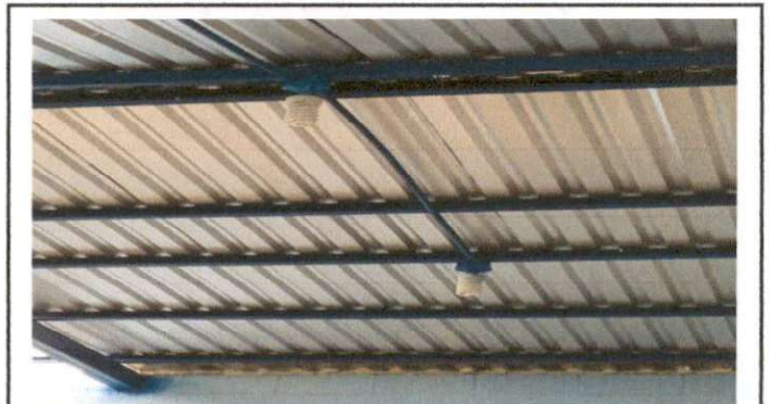
Foto 4: Tercer salón con estructura y cubierta de lámina lo que evitará futuras filtraciones de agua
