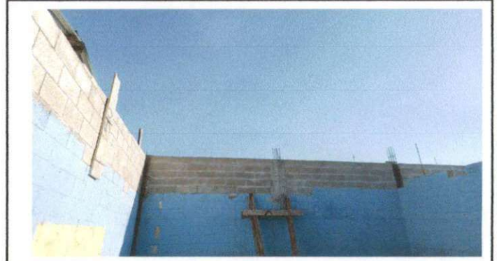
Foto 2: Segundo salón con levantado de pared previo a la colocación de la nueva estructura, esto para mejorar el desnivel y evitar filtraciones
