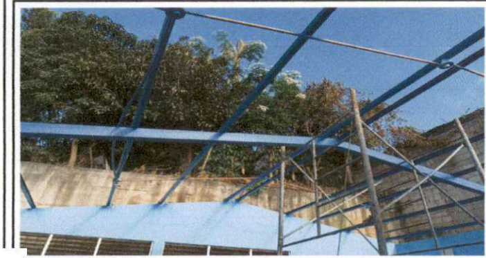
Foto 1: Mantenimiento a la estructura del primer salón previo a la colocación de la lámina nueva
