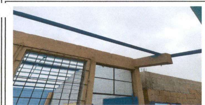
Foto 5: Colocación de costaneras y mantenimiento de las mismas en el pasillo donde se tenía filtración de agua por el estado de lámina y costanera
