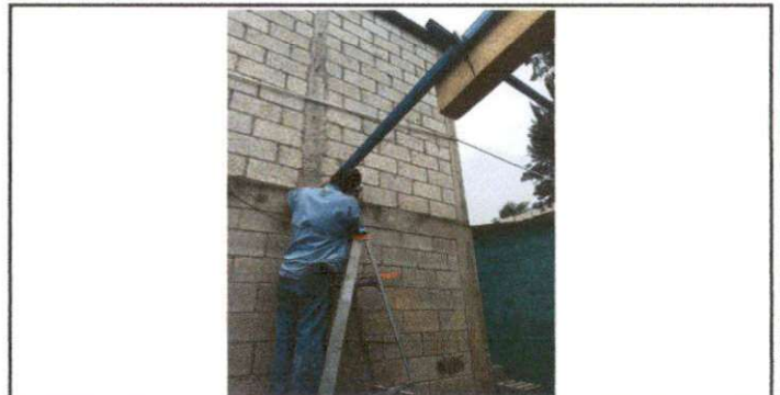
Foto 6: Colocación de estructura para ubicar el canal que conducirá el agua a través de un nuevo conducto, evitando el agua en los salones
