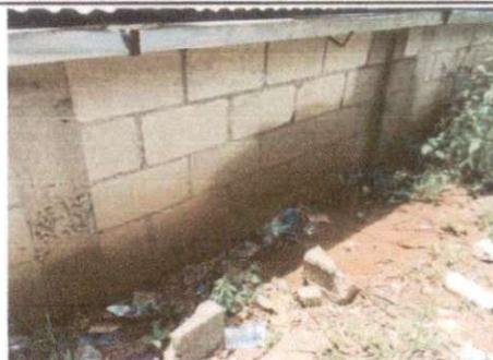
Foto 6: Situación actual del canal y filtración de agua
