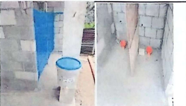
Foto 3: la escuela no cuenta con calidad de mingitorio y lavamanos por lo que se deben sustituir.
