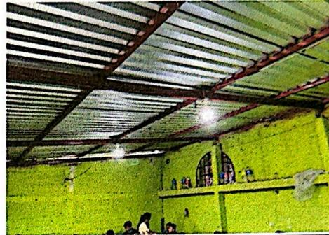
Foto 2: Suministro e instalación de lámina troquelada en salón de clases.
