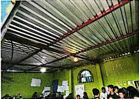
Foto 1: Mantenimiento a estructura de techo, incluye lijado y pintura mas instalación de lámina troquelada nueva.
