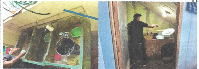
Foto 4: Espacio de pila de cocina a repellar y azulejar
