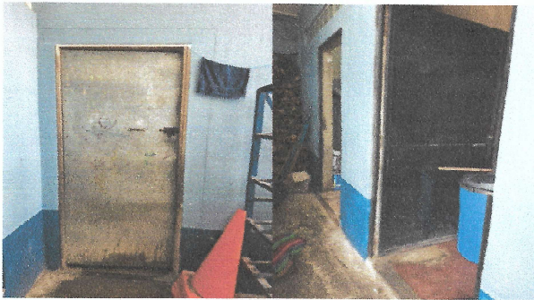
Foto 3: Sustitución de puertas de la cocina, bodega y pila
