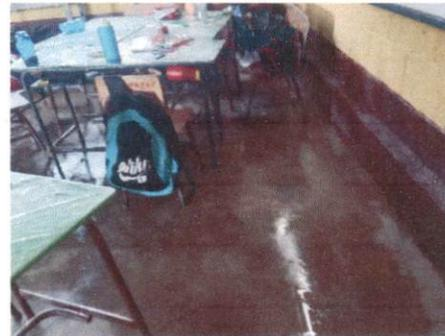
Foto 2: Derivado a la filtración de agua en las paredes, es necesario el remozamiento en la parte de atrás de dos aulas con el material impermeabilizante de buena calidad color gris.
