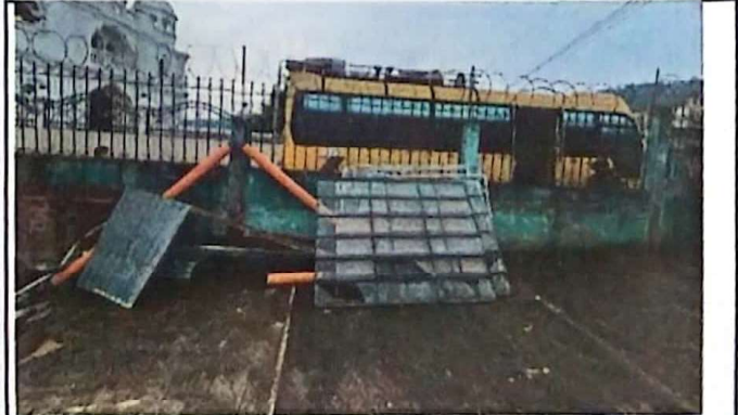
Foto 6: Continuidad de pared de block en entrada principal
