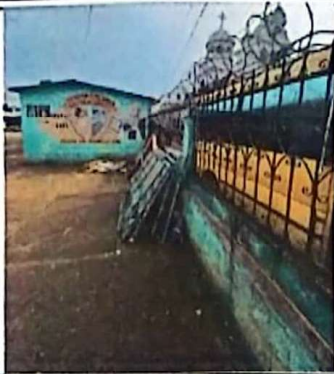
Foto 7: Tallado de muro perimetral, entrada principal
