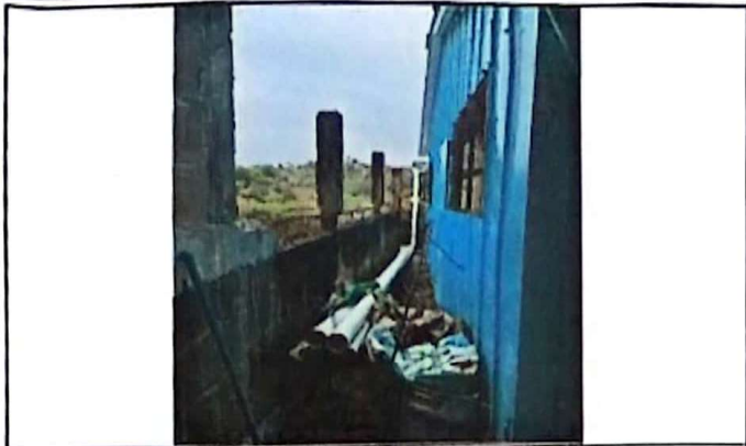
Foto 1: Continuidad de circulación de cerco perimetral con malla
