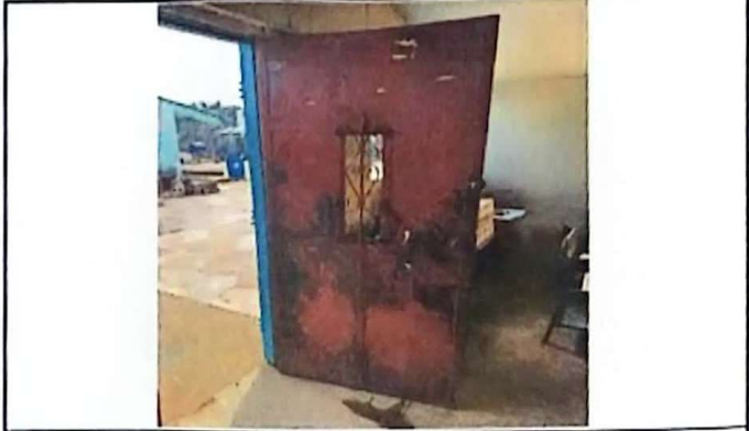
Foto 4: Reparación de puertas
