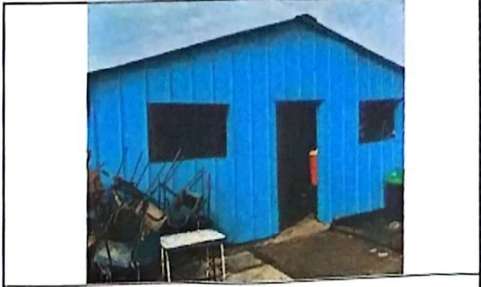
Foto 2: Instalación de ventanas
