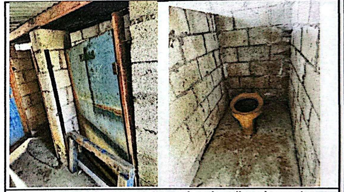
Foto 10: Internamente no se cuenta con piso, ni repellos, y las puertas están en malas condiciones.
