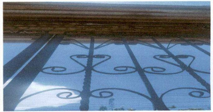
Foto 2: Cambio de portón de la entrada del establecimiento y techado para protección del portón.
