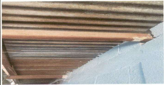
Foto 6: Sustitución de cubierta de lámina, por lámina troquelada aluzinc legitima.
