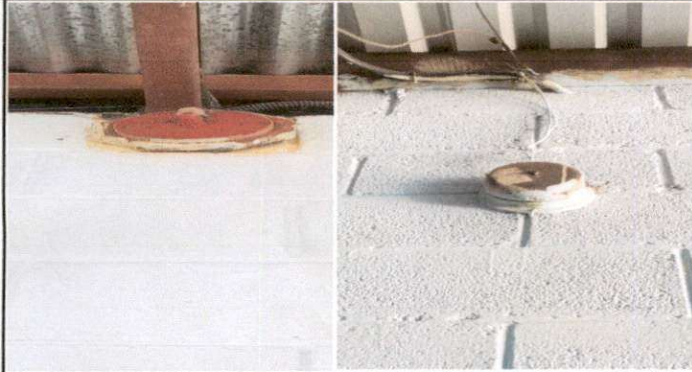
Foto 7: Sustrucción de timbres.
