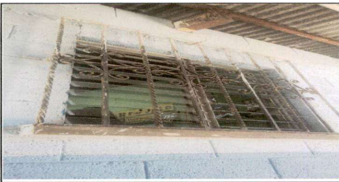
Foto 11: Mantenimiento de balcones, limpieza y pintura.
