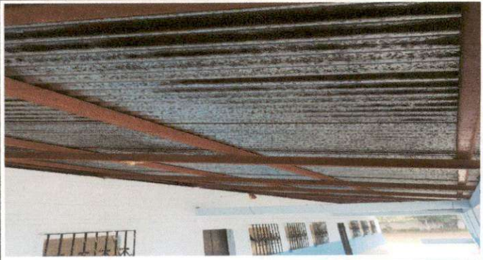
Foto 4: Mantenimiento de estructura metálica del techado, limpieza y pintura.
