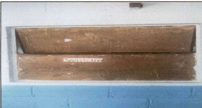
Foto 9: Sustrucción de ventanas, para mejorar la ventilación e iluminación.
