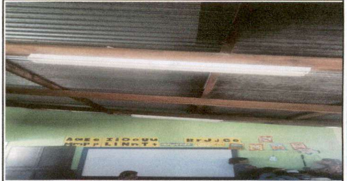
Foto 8: Sustrucción de lamparas por focos
