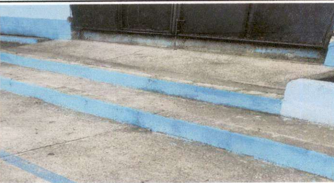
Foto 3: Sustitución de gradas por rampa de losa.
