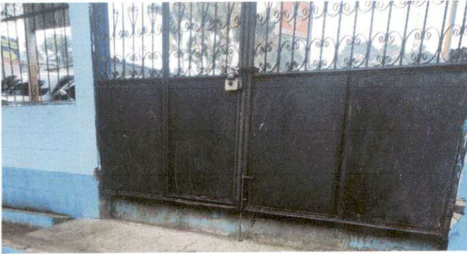
Foto1: Cambio de portón de la entrada del establecimiento y techado.
