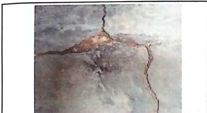
Foto 5: Es importante sustituir la torta deteriorada por una fundición de concreto.
