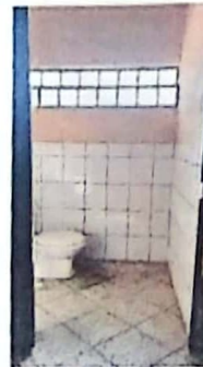
FOTO 4: Imagen que muestra el estado actual del área donde se realizará el ingreso a la cocina.
