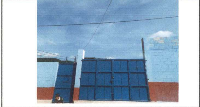
Foto 2: Mantenimiento a portones, pintura interior y exterior.
