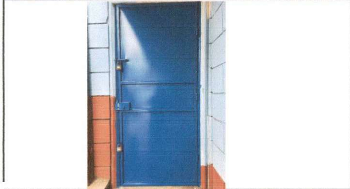
Foto 1: Sustitución de 1 puerta y mantenimiento a estructura.
