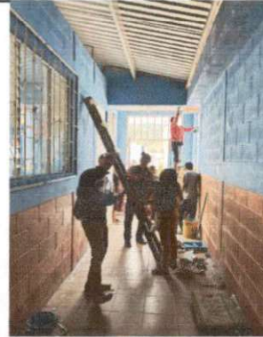
Foto 2: Mantenimiento a portones, pintura interior y exterior.
