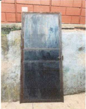
Foto 1: Sustitución de 1 puerta y mantenimiento a estructura.
