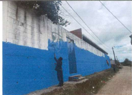
Foto 6: Pintura en muros exteriores.
