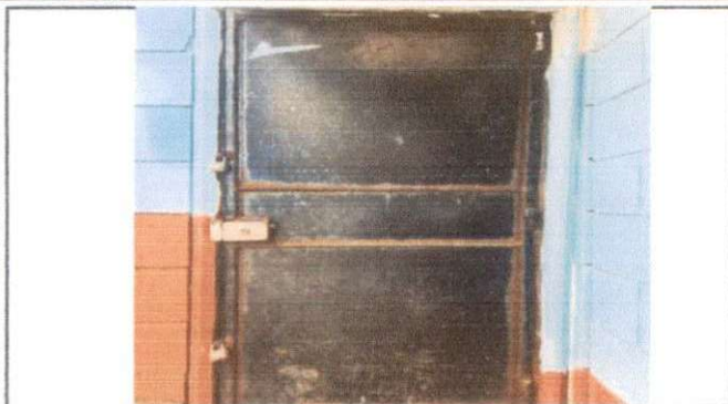
Foto 1: Sustrucción de 1 puerta y mantenimiento a estructura.
