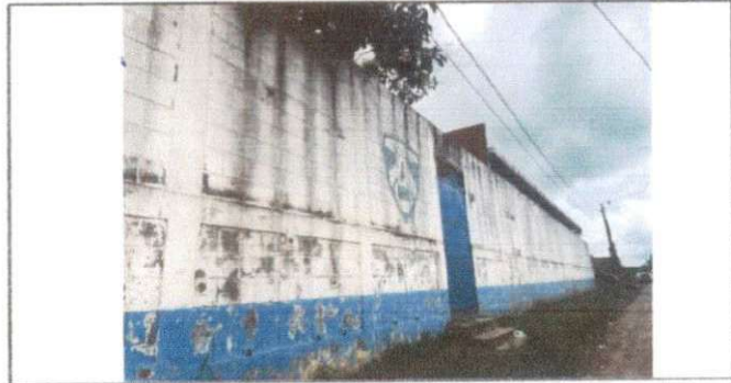
Foto 6: Pintura en muros exteriores.
