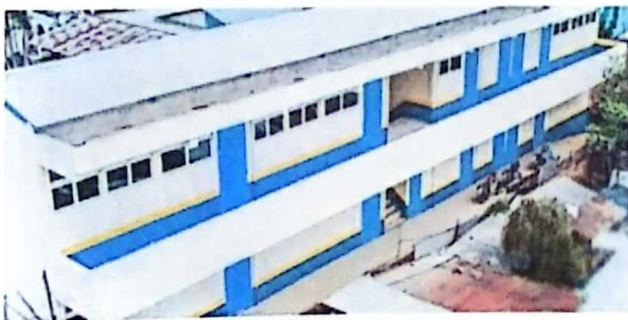
Foto 9: PASILLO (PLANTA ALTA)
