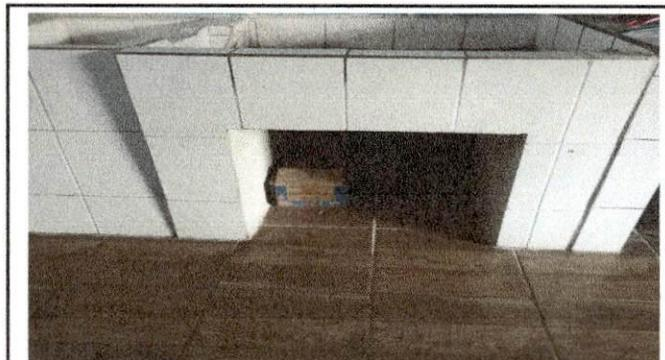
Foto 4. Pila de la cocina se amplió el lavadero del lado derecho y tampizado con azulejo
