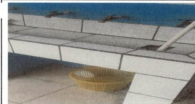
Foto 5. Corrección del drenaje del lavamanos de los servicios sanitarios del módulo I
