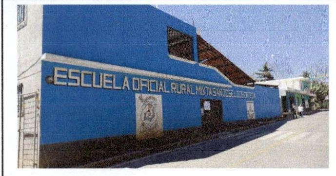
Foto 1. frente de la EORM "Caserío San José Lo de Ortega" se desea colocar banquetas, y cubrir los tubos .
