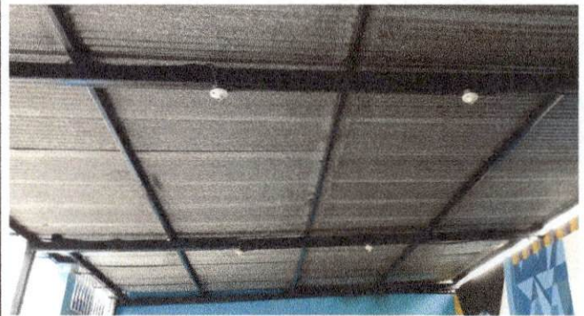
Foto 2. La instalación eléctrica que está en el escenario del patio.
