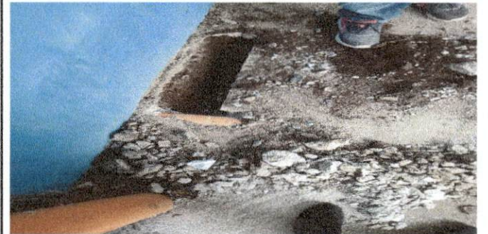
Foto 6. Cambiando de lugar la pila del patio, de la escuela.
