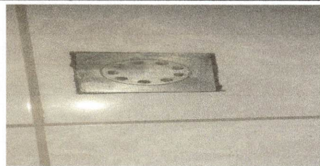
Foto 5. Reparación del drenaje que se encuentra en los servicios sanitarios del módulo I.
