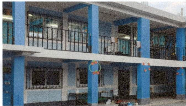
Foto 3. Cambio de ventanas de marco de metal, por PVC.
