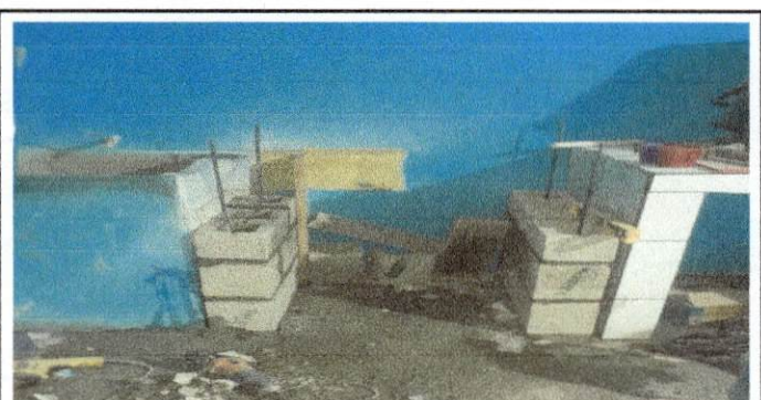
Foto 4. Pila de la cocina se amplio el lavadero del lado derecho y tampizado con azulejo
