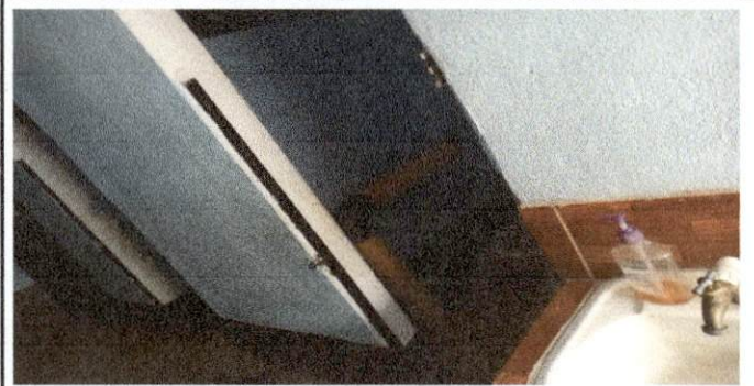
Foto 4. Quitando las puertas de los servicios sanitarios del módulo I, para pintarlas y arreglarlas.
