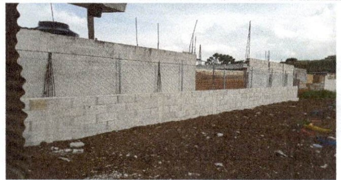
Foto 4. Remozamiento de una parte del muro, perimetral.
