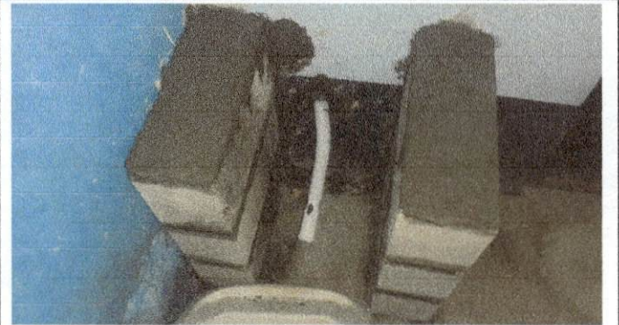
Foto 2. Colocación de la base del lavamanos por donde se ubica el mijitorio.
