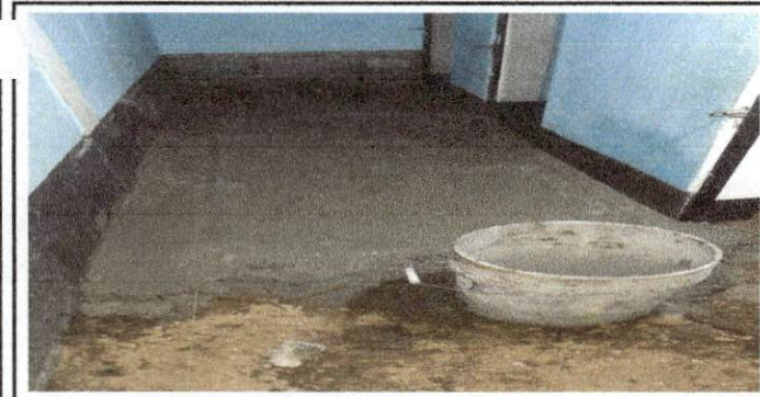
Foto 5. Reparación del drenaje que se encuentra en los servicios sanitarios del modulo I.
