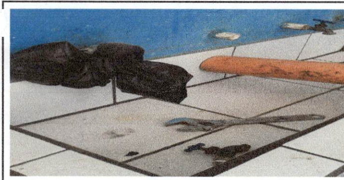
Foto 5. Cambio de los chorros del lavamanos del servicio sanitario del modulo I
