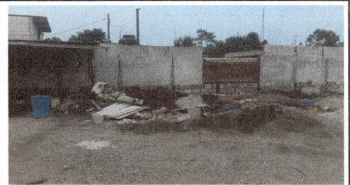
Foto 4. Remozamiento de una parte del muro, perimetral.
