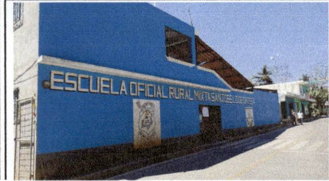
Foto 1. frente de la escuela, entrada principal de la E.O.R.M. "Caserío San José Lo de Ortega" Se observa la calle principal que es muy peligro ya que no se cuenta con una banqueta y los carros pasan muy rapido, por eso se utiliza, la parte de atrás para que los estudiantes se retiren del establecimiento.
