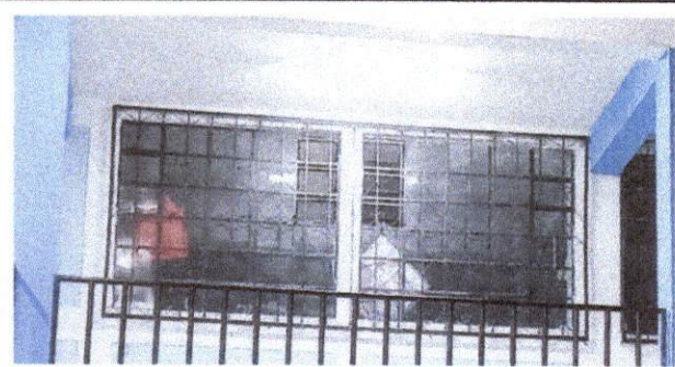
Foto 4. Constan de un buen tamaño, pero se necesita cambiar para que se puedan abrir.
