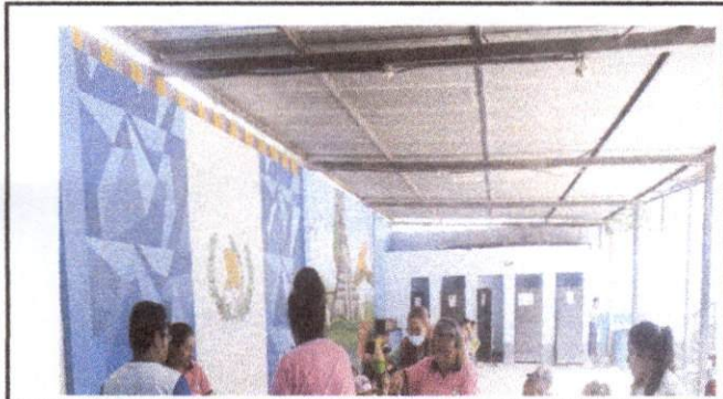
Foto 3. Remozamiento de costaneras del escenario
