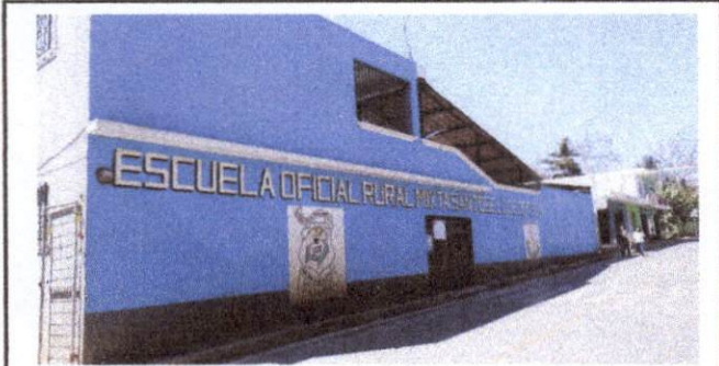
Foto 1. frente de la EORM "Caserío San José Lo de Ortega" se desea colocar banqueta, y cubrir los tubos .
