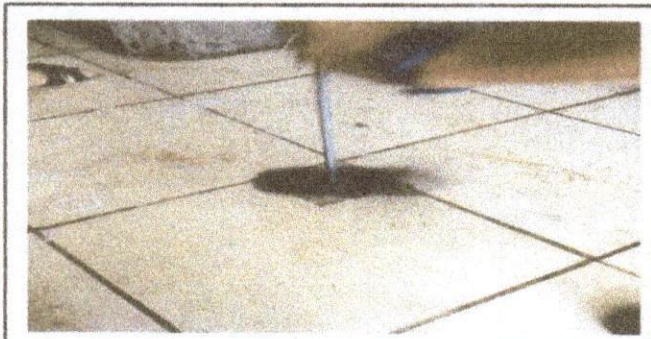
Foto 5. Reparación del drenaje que se encuentra en los sanitarios, ya que es una fosa ceptica.
