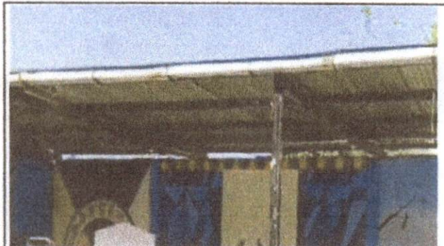
Foto 4. El cambio de canales de agua pluvial
