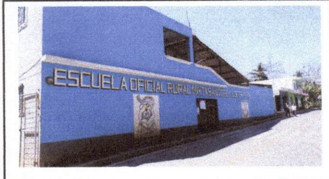
Foto 1. frente de la EORM "Caserío San José Lo de Ortega" se desea colocar banqueta, y cubrir los tubos .
