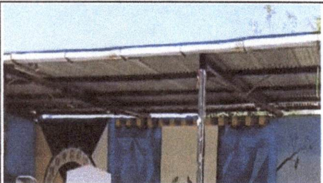
Foto 4. El cambio de canales de agua pluvial
