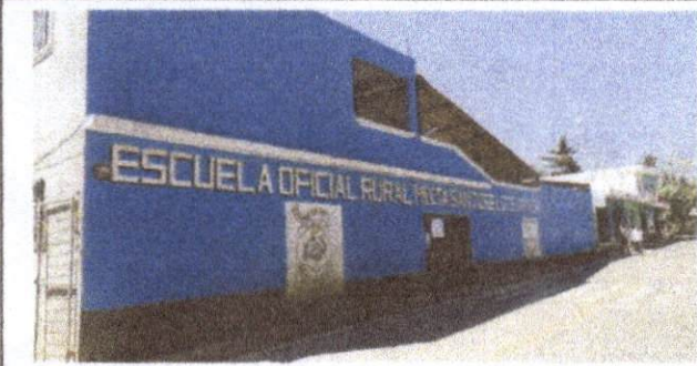
Foto 1. frente de la EORM "Caserio San José Lo de Ortega" se desea colocar banqueta y cubrir los tubos.
