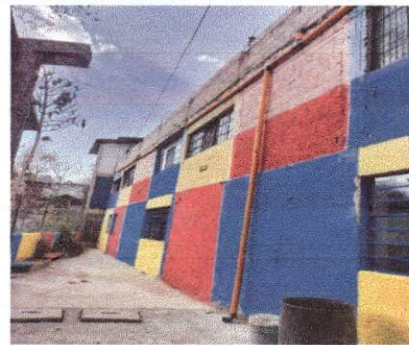
Foto 12: En la presente imagen del modulo 1 se observa la bajada de agua pluvial a la cual se le dara reparación.
