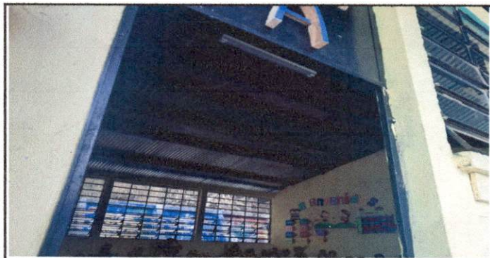
Foto 5: salón dos, donde se cambiará la lámina por losa, que posteriormente será ocupado por el grado de primero básico.
