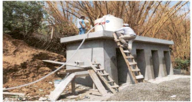
Foto 4: INSTALACIÓN DE TUBERIAS PARA CISTERNA/DEPÓSITO DE AGUA
