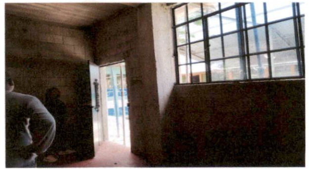
Foto 6: COLOCACIÓN DE VENTANAS PARA SALÓN 4
