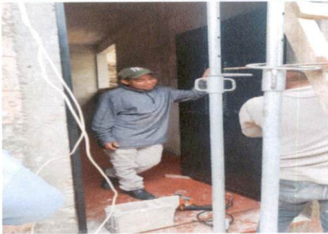
Foto 5: COLOCACIÓN DE PUERTA SALÓN 4
