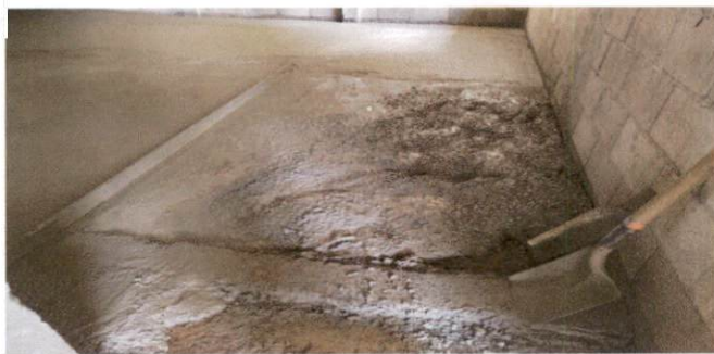
Foto 5: FUNDICIÓN DE TORTA DE CONCRETO PARA SALÓN 4
