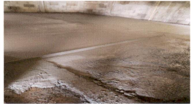
Foto 4: FUNDICIÓN DE TORTA DE CONCRETO PARA SALÓN 4
