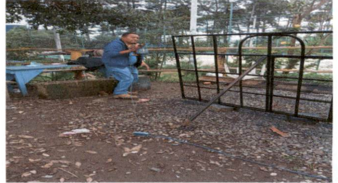
Foto 2: ELABORACIÓN DE VENTANAS PARA SALÓN 4
