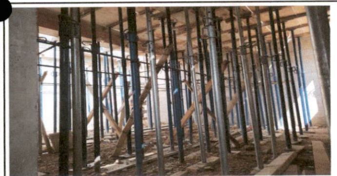
Foto 5: COLOCACIÓN DE TRIKET PARA LOZA DE SALÓN 4
