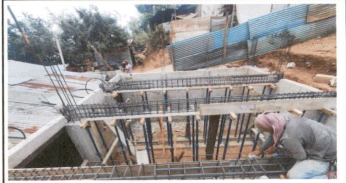
Foto 4: COLOCACIÓN DE ARMADURA DE COLUMNAS PARA LOZA DE SALÓN 4
