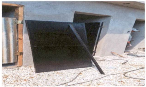
Foto 4: COLOCACIÓN DE PUERTAS PARA SANITARIOS 1,2,3 Y 4
