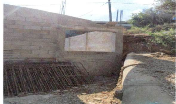
Foto 6: IMAGEN ACTUAL DE VENTANA DE SALÓN 4
