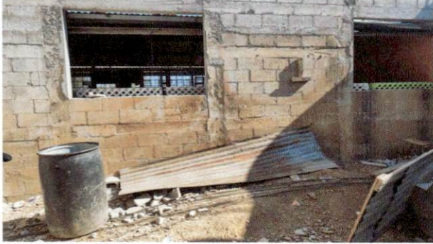
Foto 7: IMAGEN ACTUAL DE VENTANA DE SALÓN 4
