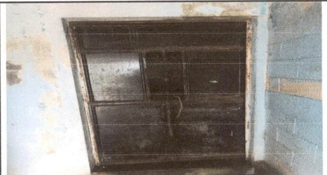
Foto 4: mantenimiento de puertas
