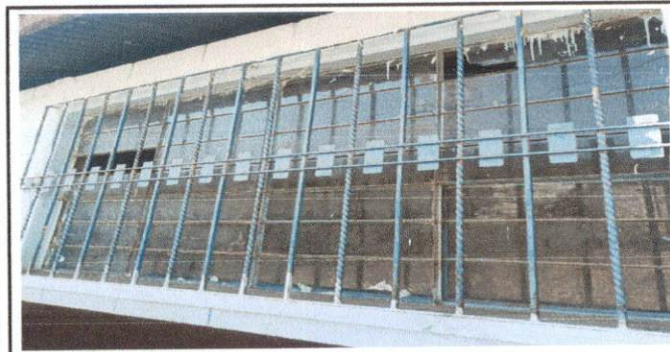
Foto 5: Mantenimiento de ventanas
