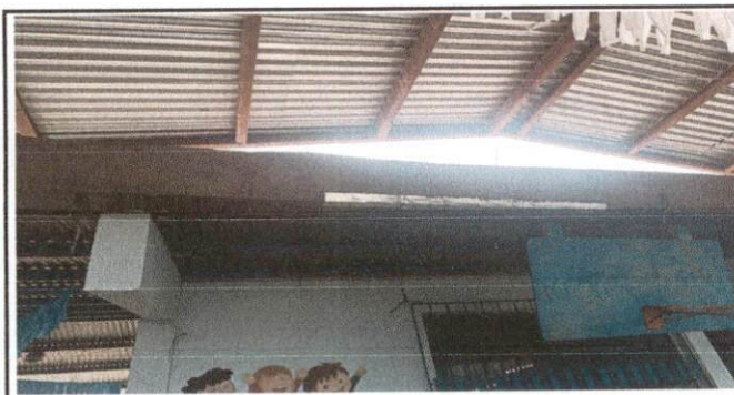
Foto 3: cambio de canaletas
