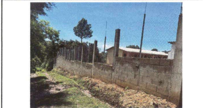
Foto 3: Cernido gris en cerco perimetral
