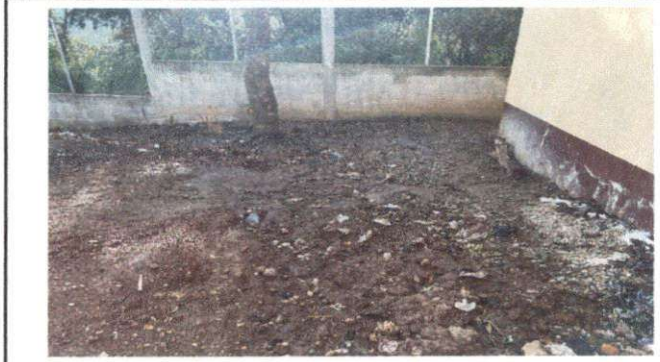
Foto 4: Compactación y sellado de pozo séptico
