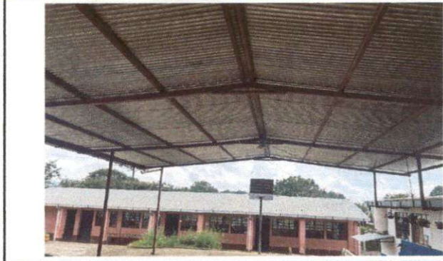
Foto 2: Refuerzo de estructura metálica
