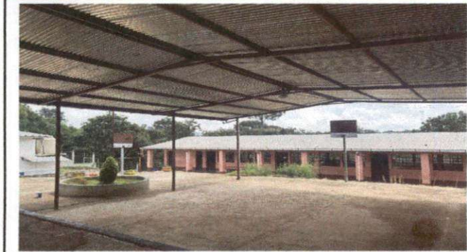
Foto 1: Sustrucción de cubierta de lámina existente
