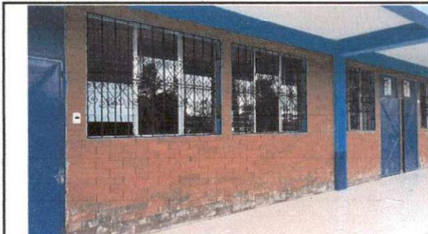
Foto 5: Instalación de balcones en todas las ventanas del primer nivel finalizado.
