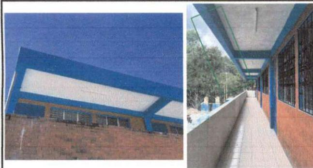
Foto 3: Se reparó de losa del segundo nivel debido a filtraciones de agua aplicando hilera de block y pintando la losa.
