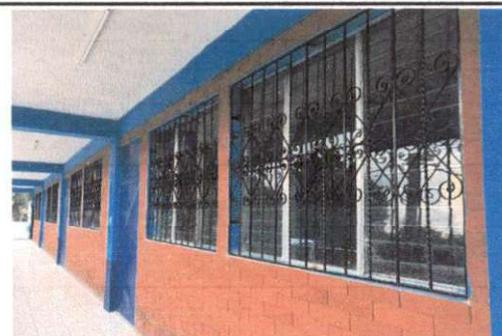
Foto 6: Instalación de balcones en todas las ventanas del segundo nivel finalizado.
