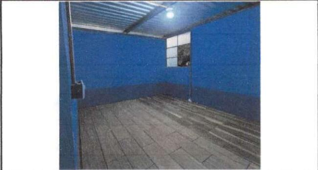
Foto 7: Aplicación de cernido y pintura en paredes de cocina. Sustitución de torta de concreto por piso.
