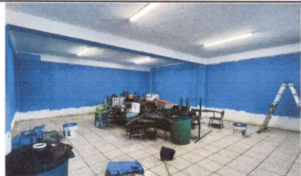
Foto 2: Aplicación de pintura dentro de los salones de clase.
