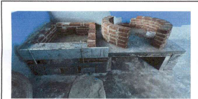
Foto 9: Proceso de sustitución completa de estufa rural.
