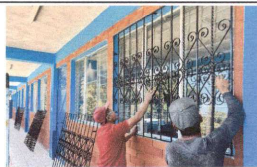
Foto 6: Colocación de balcones en todas las ventanas del primer nivel para mayor seguridad debido a la falta de muro perimetral en el establecimiento.
