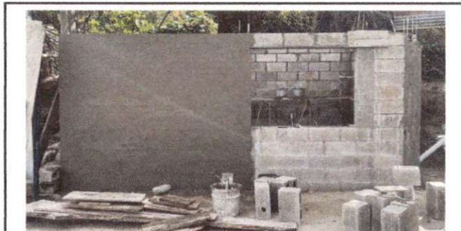
Foto 10: Proceso de sustitución de estructura y cubierta con lámina troquelada.
