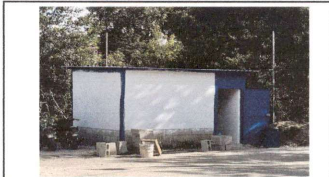
Foto 8: Aplicación de cernido en paredes en exteriores de cocina.
