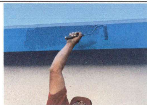
Foto 4: Reparación de losa del segundo nivel para evitar filtraciones de agua aplicando encima una hilera de block y pintura sobre la losa.
