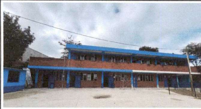
Foto 1: Aplicación de pintura en los exteriores del establecimiento.
