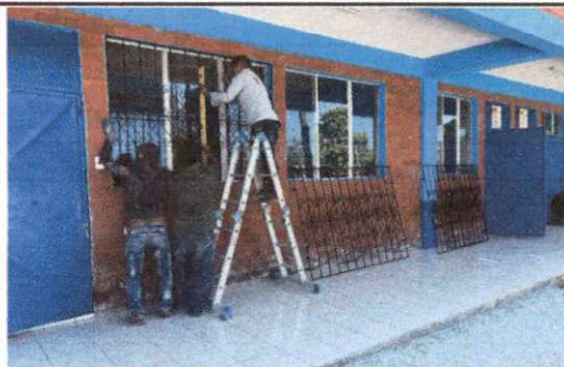
Foto 5: Colocación de balcones en todas las ventanas del primer nivel para mayor seguridad debido a la falta de muro perimetral en el establecimiento.
