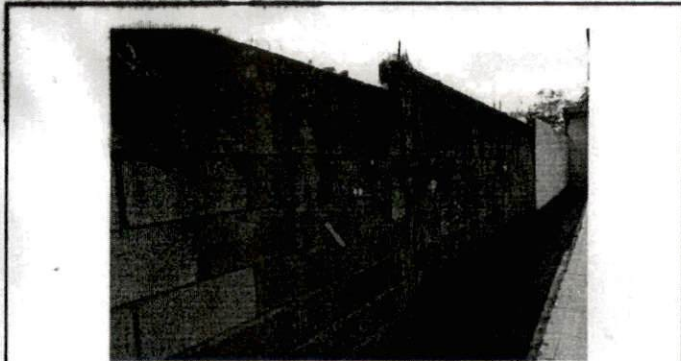
Foto 7: Estado como se encuentran los muros perimetrales, rusticos y expuestos
